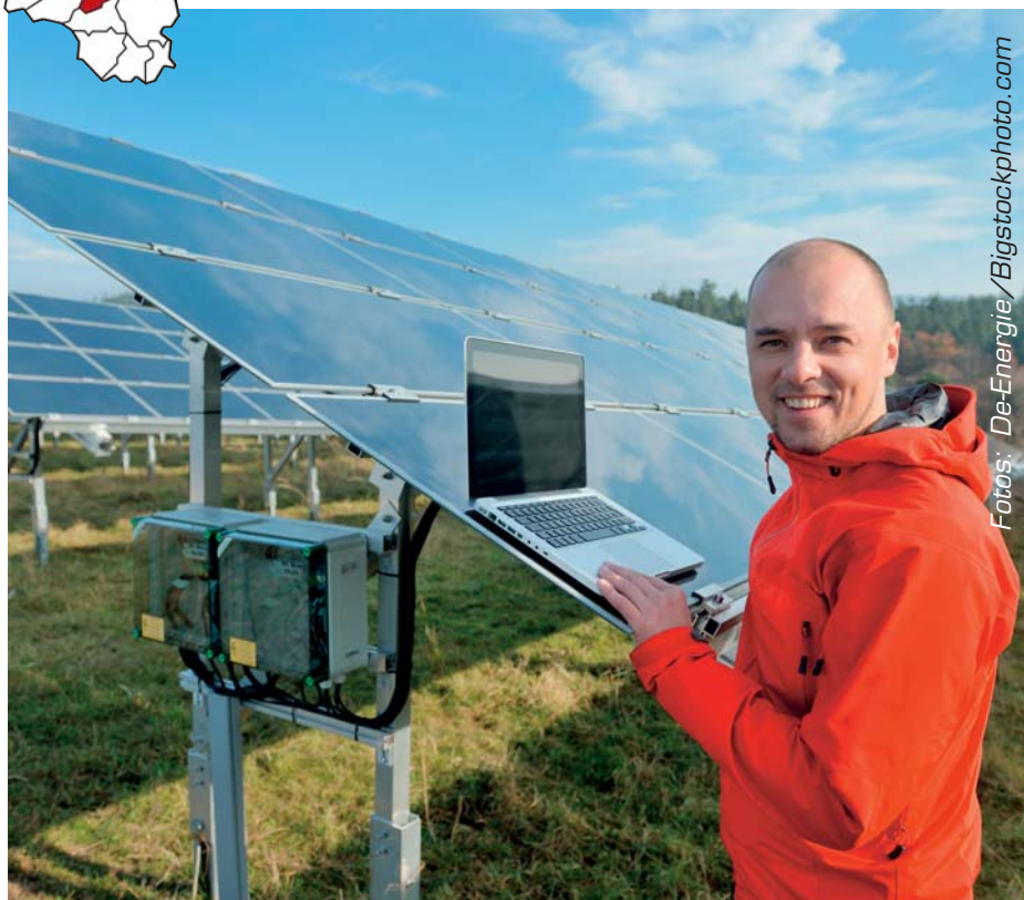
Service-Techniker bei der Wartung einer Solaranlage.
