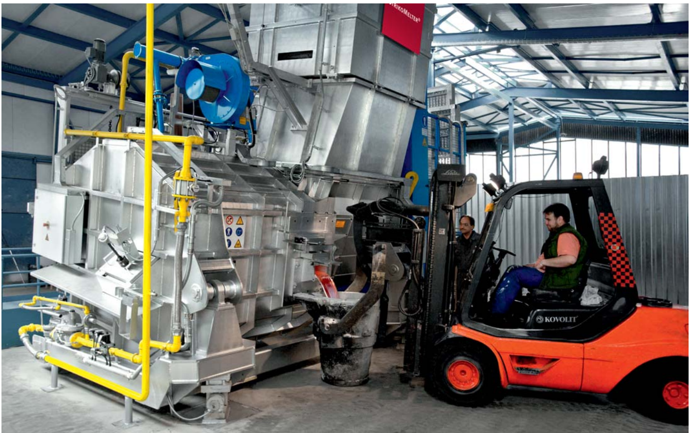
Einbau eines Striko Melter der neuen Baureihe PurEfficiency in der tschechischen Aluminium-Druckgießerei Kovolit a.s.
